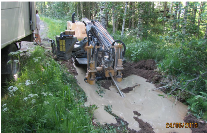
Kuva: Vesijohdon tienalitukset Museotiellä ja Korpelanniementiellä Suuntaporauslaitteisto
